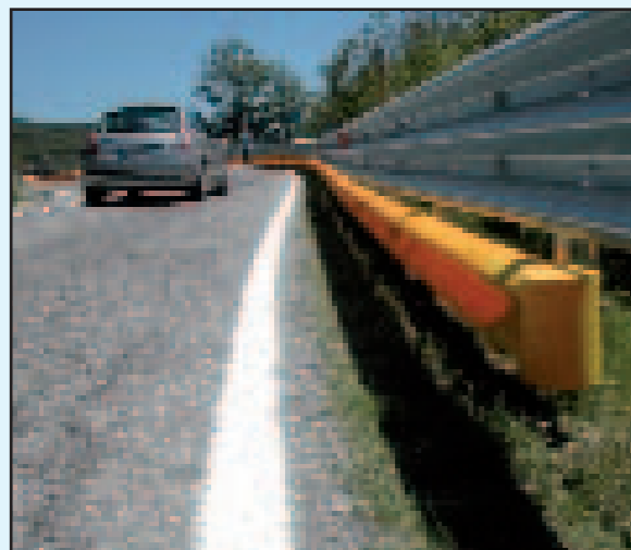
A sinistra: il nuovo guard-rail installato con il particolare cordolo in gomma.
